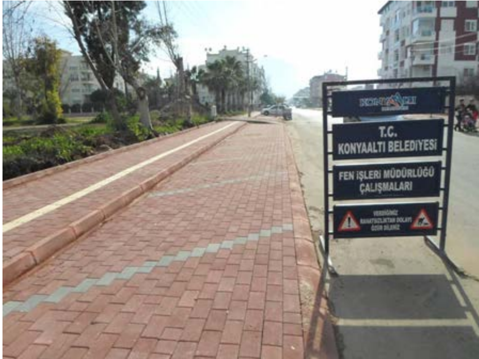
Liman Mahallesi 13 Sokak kaldırım yapımı.
