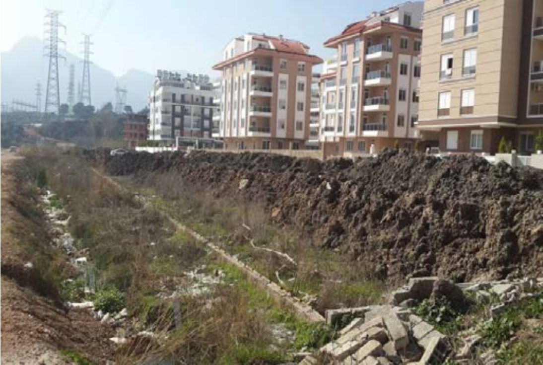
Muhtesat kamulaştırması yapıldıktan sonra sokağın durumu
