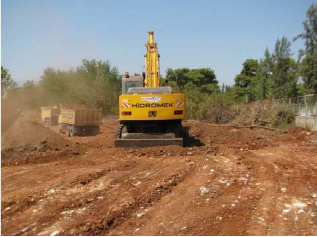
Mollayusuf Mahallesi 1412 Sokak Ham Yol Açma Çalışmaları
