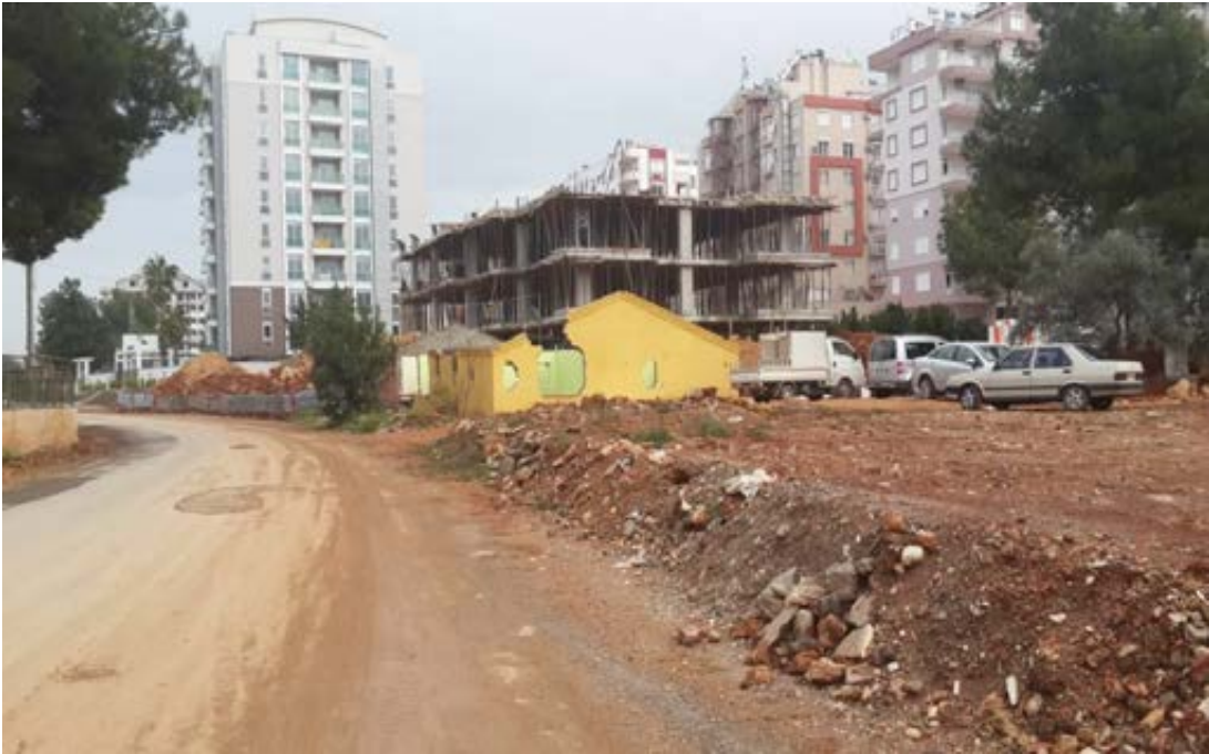
Muhtesat kamulaştırması yapıldıktan sonra sokağın durumu
