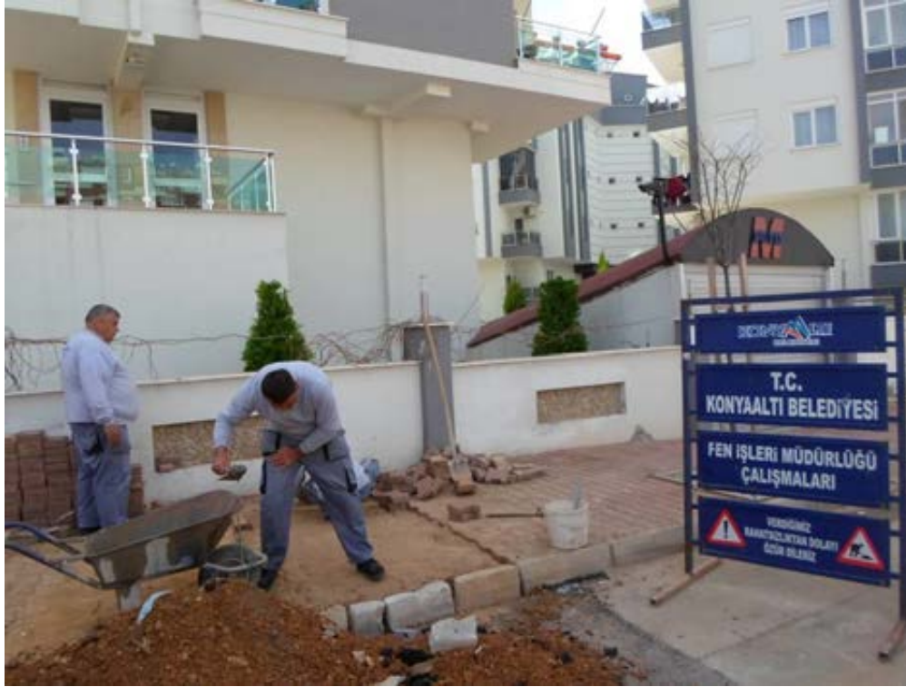
Mollayusuf Mahallesi 1427 Sokak Tamirat Ekibi çalışması
