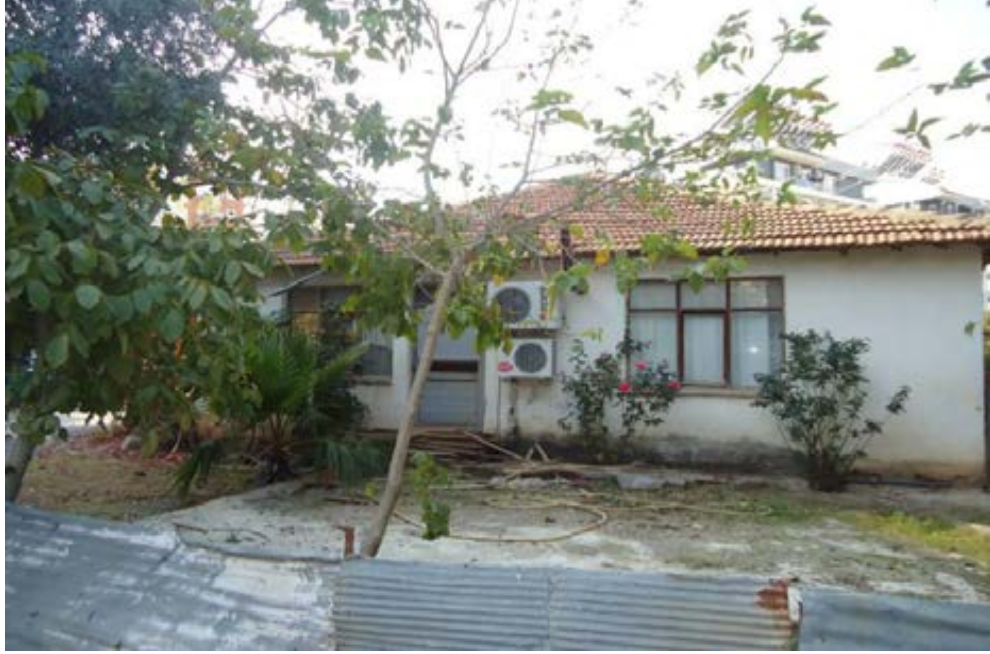
Muhtesat kamulaştırılması yapılmadan önce sokağın durumu.
