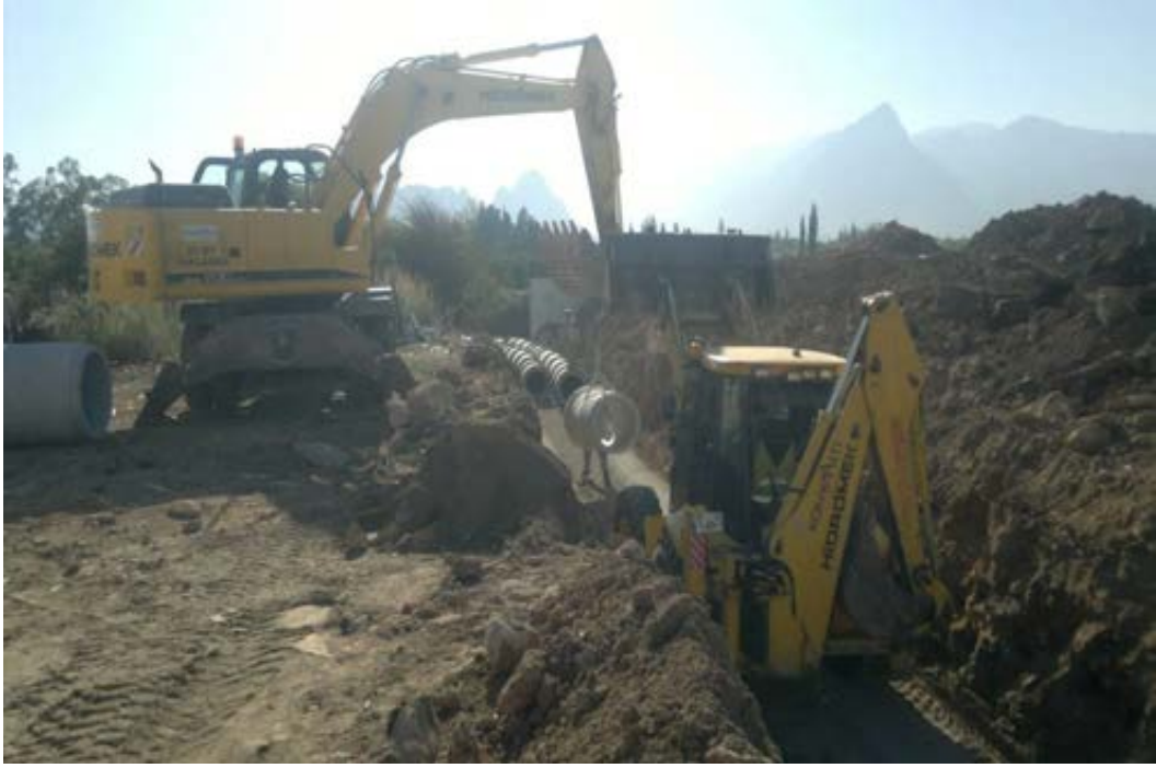
Mollayusuf Mahallesi 1448 – 1454 Sokak kesiÇmi yağmursuyu drenaj hattı yapımı.
